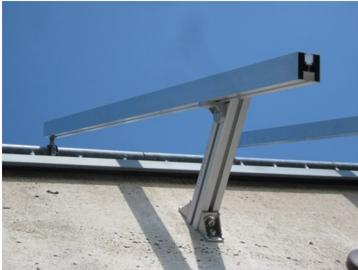
Montierte Einheit, Neigungswinkel beträgt hier 65°
