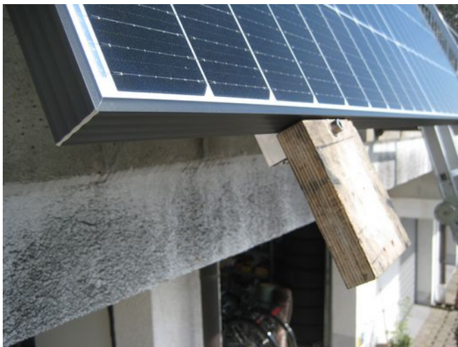
Holzklötze als Hilfsanschlag unten während der Randklemmen-Montage
